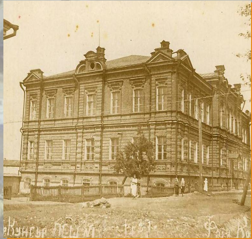
ВИД ЗДАНИЯ ШКОЛЫ №10
