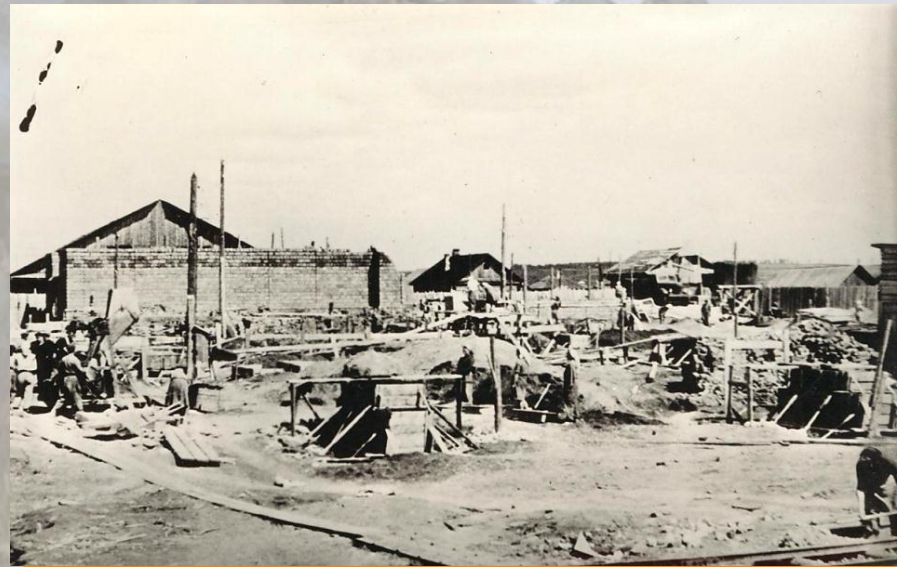
СТРОИТЕЛЬСТВО ПОДСТАНЦИИ ВЫСОКОВОЛЬТНОЙ ЛИНИИ
