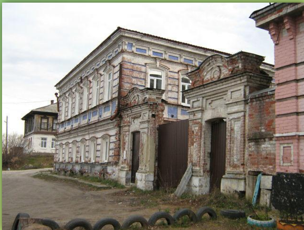
Здание начальной школы №5, ныне отдел МО МВД «Кунгурский», 2000-е гг.
