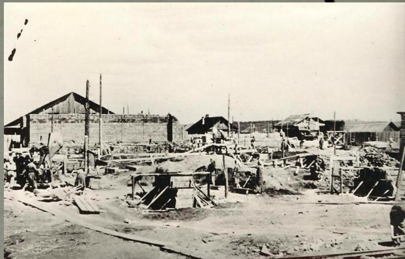
Идет строительство подстанции высоковольтной линии, БФ, д.820
