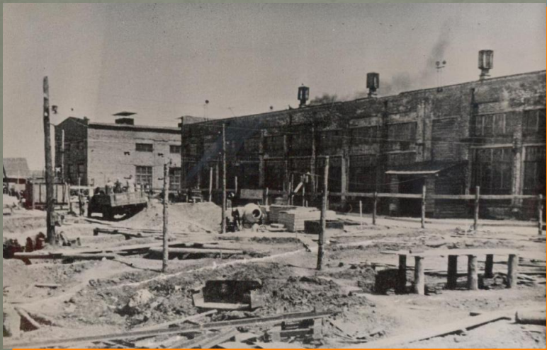
Строительство Механосборочного цеха машзавода, БФ, д.820
